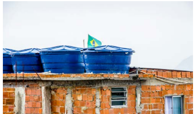
Şekil 22: Sao Paulo'da yağmur suyu toplama tankları.
