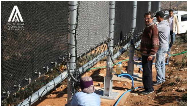
Şekil 24: Fas'ın Atlas Dağları'na kurulan dünyanın en büyük "sis yakalayıcı" sisteminin bir bölümü.
