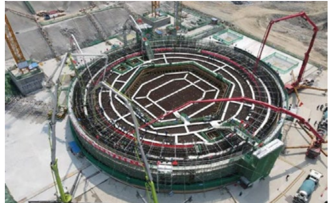
Şekil 4: Çin’in Changjiang Nükleer Santrali’nde inşası devam eden küçük modüler reaktör çalışması [26] .
