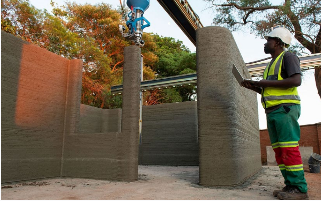
Şekil 48: Üç boyutlu bina yazıcı [143] .
