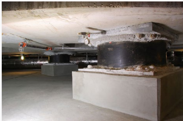
Şekil 51: Sismik taban izolatörü.
