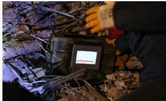
Şekil 23: STM'nin Duvar Arkası Radar teknolojisi Kahramanmaraş merkezli depremlerde kullanılmıştır [73] .
